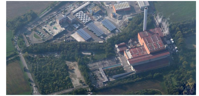
VISTA AEREA IMPIANTO
