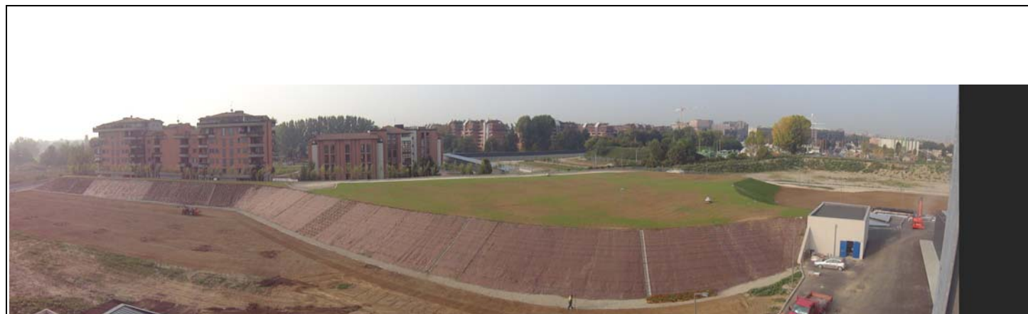
Vista da Nord-Est (collinatura)
